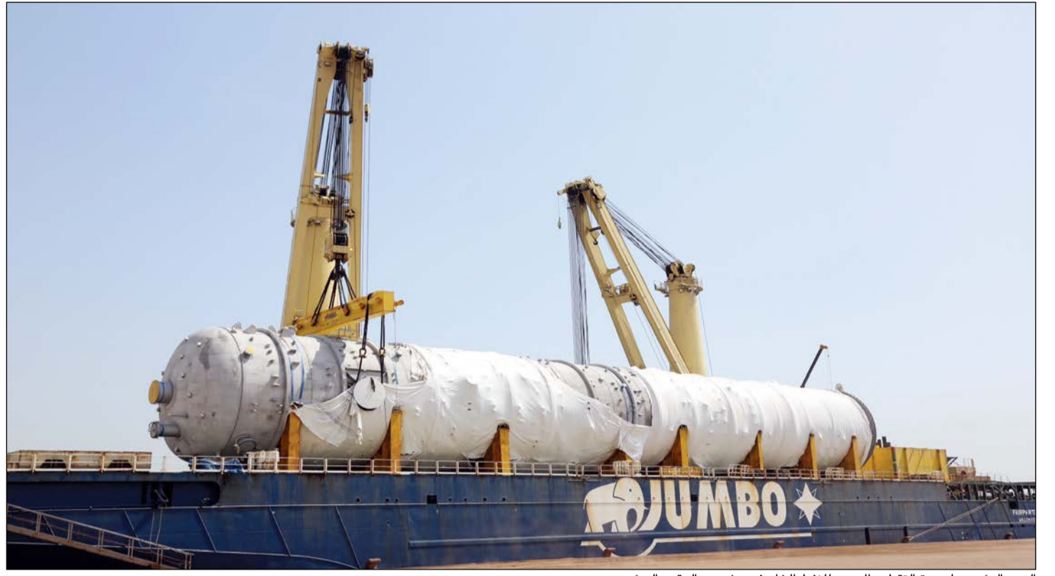
البرج الرئيسي لوحدته التقطير الجوي للنفط الخام في مشروع الوقود البيئي
