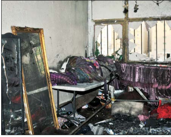
آثار الحريق بعد إخماده
