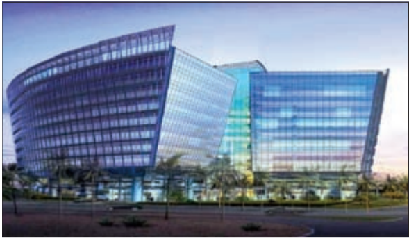
المبنى الجديد للتربية
