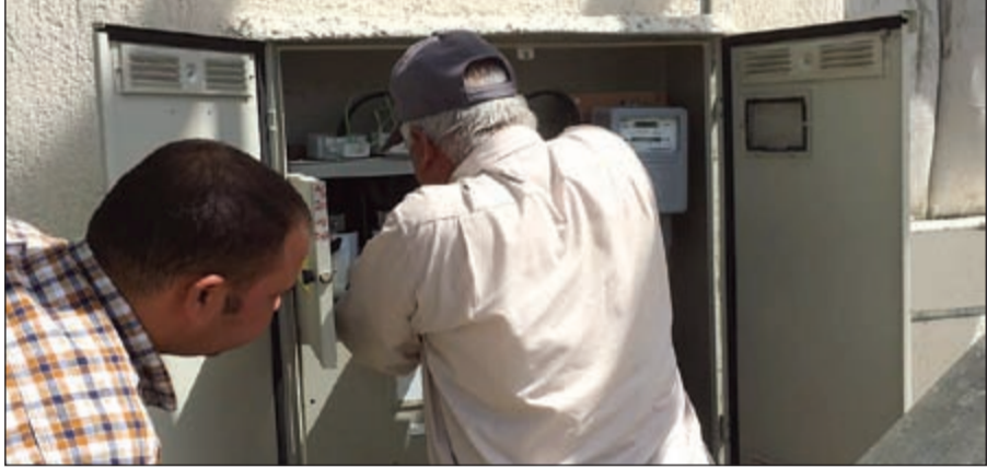
قطع التيار الكهربائي عن أحد المنازل المخالفة
