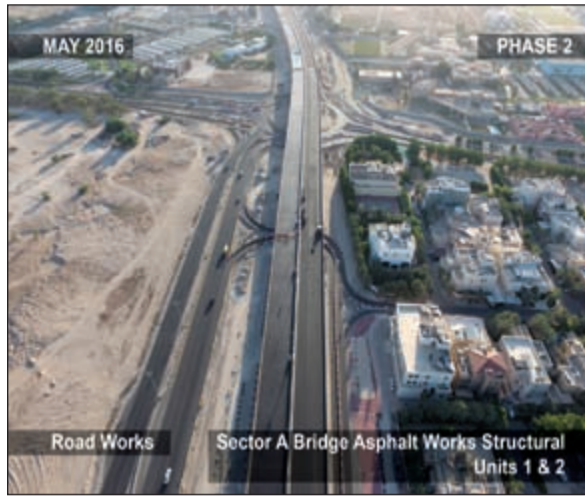
جانب من أعمال المشروع
