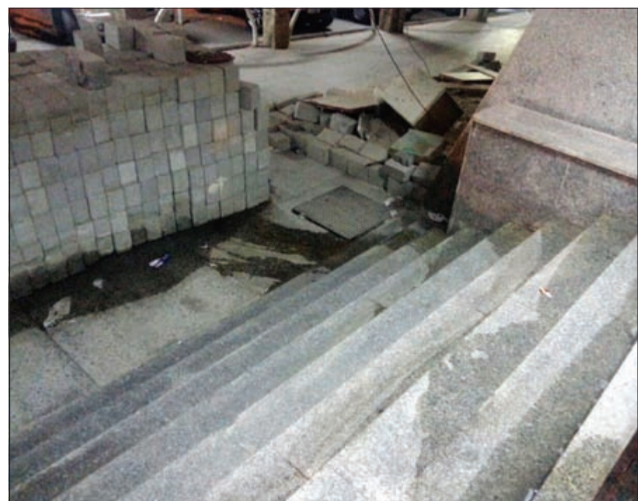
طابوق يخلق مدخل البناية
