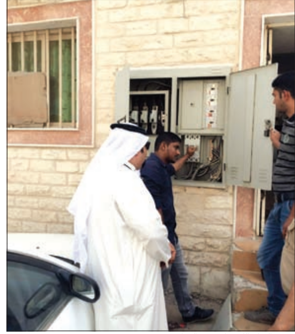
فصل التيار الكهربائي عن العقار
