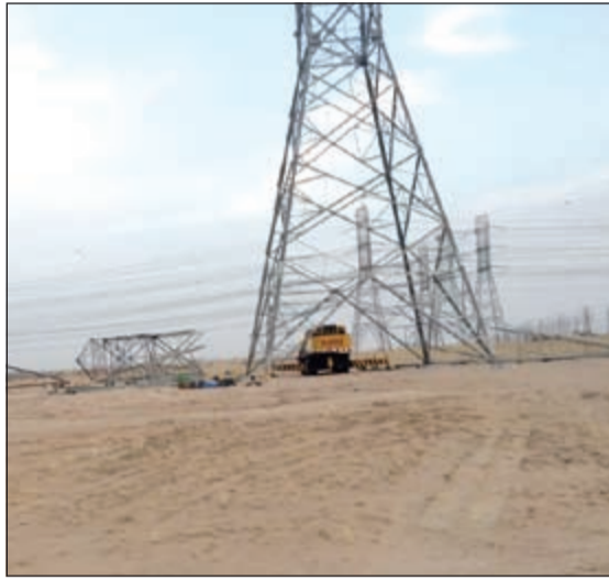
جانب من الأعمال الكهربائية في المدينة
