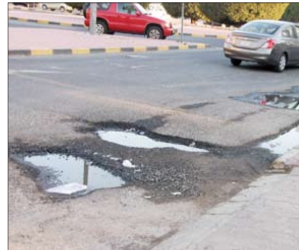
حفر في طرقات منطقة صباح الناصر
