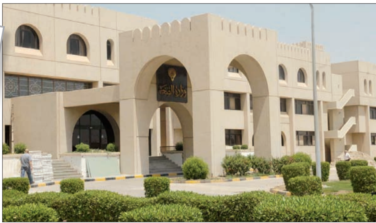
مبنى وزارة الصحة
