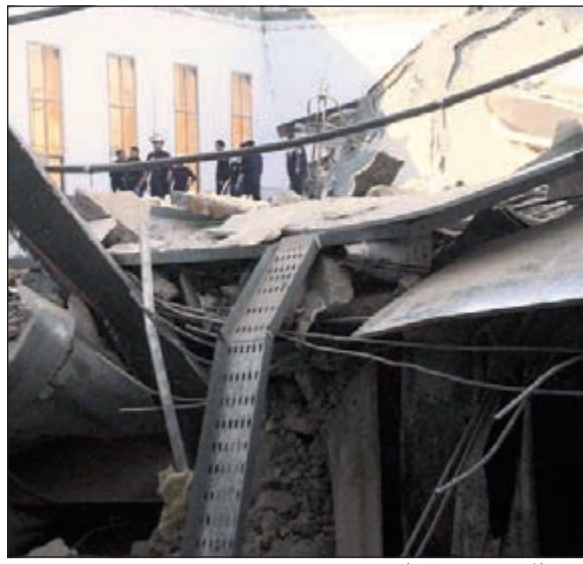
سقف المسجد بعد سقوطه
