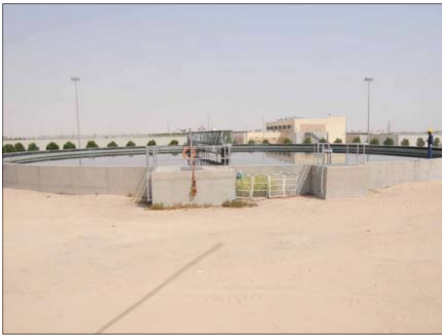
محطة كبد لتحلية المياه
