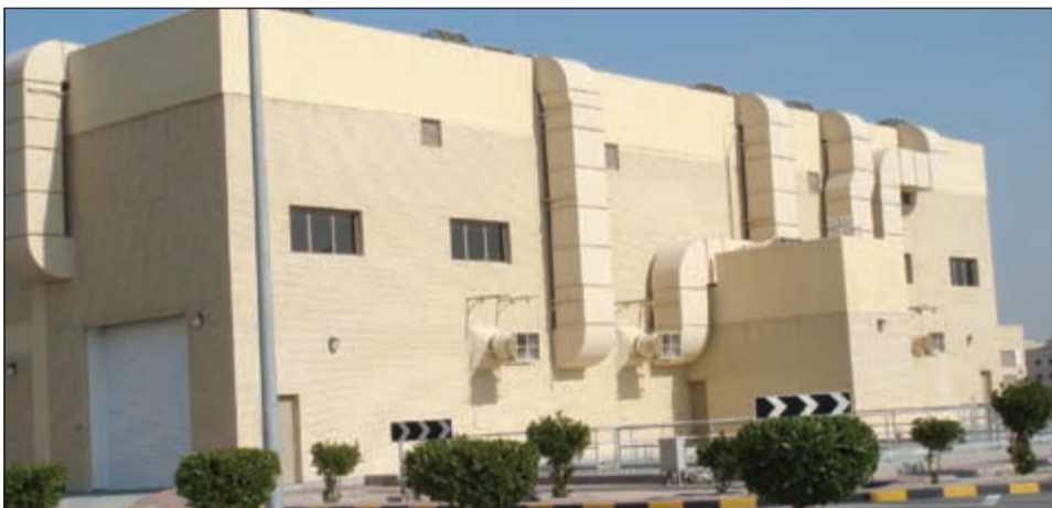
البنو الرئيسي لمحطة ضخ الجهراء
