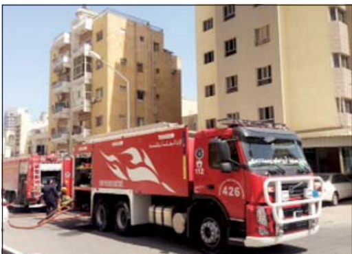
كيات الإطفاء مترفقة أمام العمارة التي تم إخلاؤها
