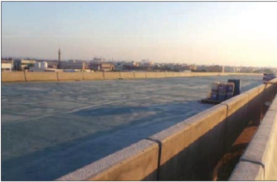
جانب من أعمال المشروع
