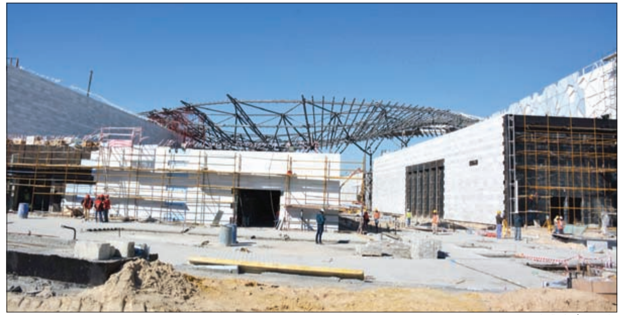
جانب من أعمال البناء
