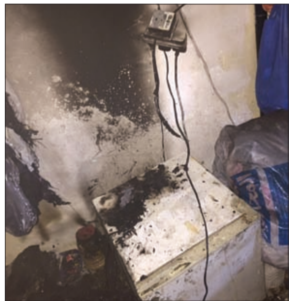
التوصيلات رديئة الصنع تسببت في الحريق
