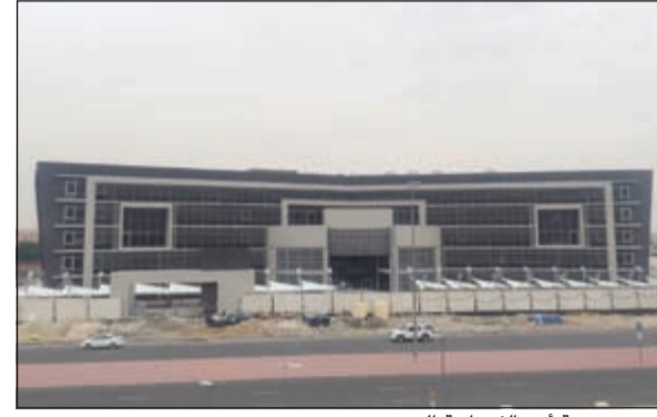
مبنى مديرية أمن الفروانية الجديد
