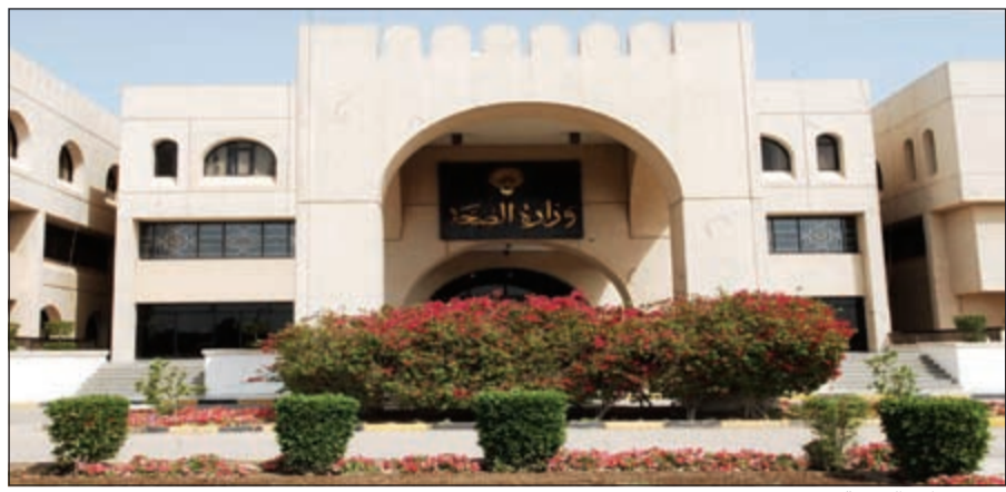
مبنى وزارة الصحة
