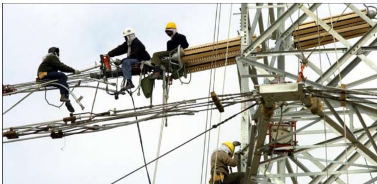
الكويت شهدت حالات انقطاع للتيار الكهربائي أكثر من مرة
