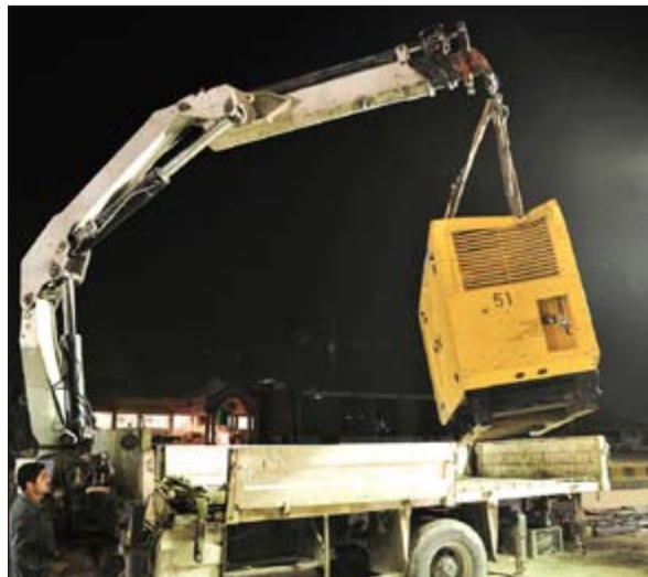
رفع احد محولات الكهرباء
