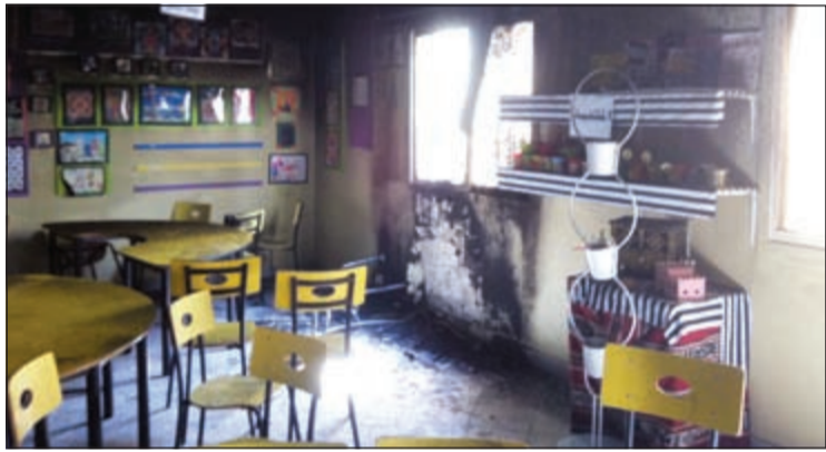
الفصل بعد إخماد الحريق
