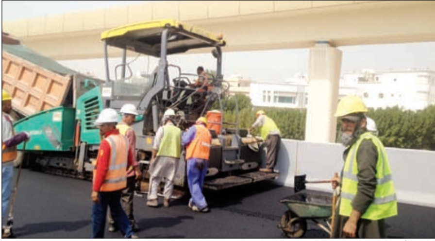
آليات «الأشغال» ومهندسو وعمال «طريق الجهراء» خلال رصف إحدى مراحل المشروع
