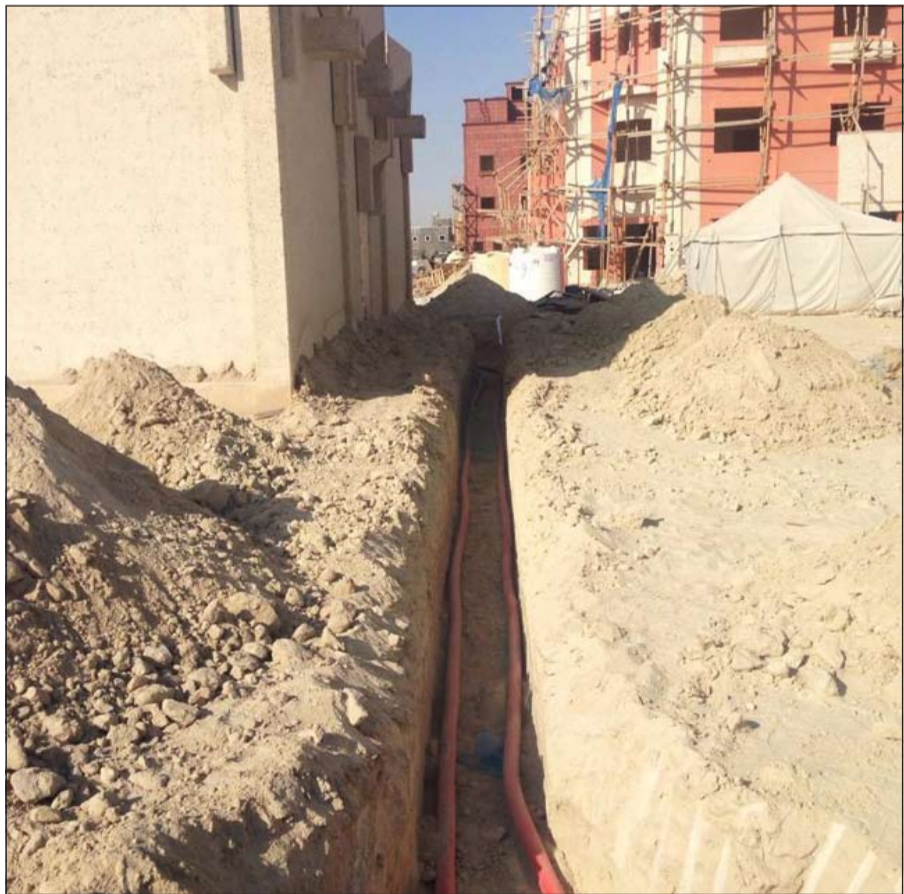
جانب من أعمال الحفر ومد الكيبلات الكهربائية في مدينة جابر الأحمد
