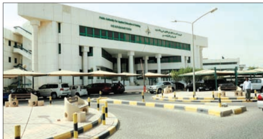
مبنى الهيئة العامة للتعليم التطبيقي والتدريب
