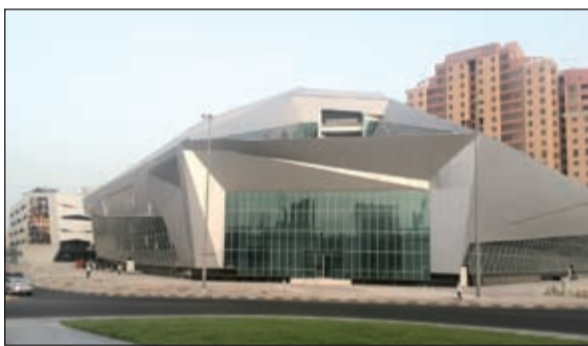
المبنى الجديد للبولينغ
