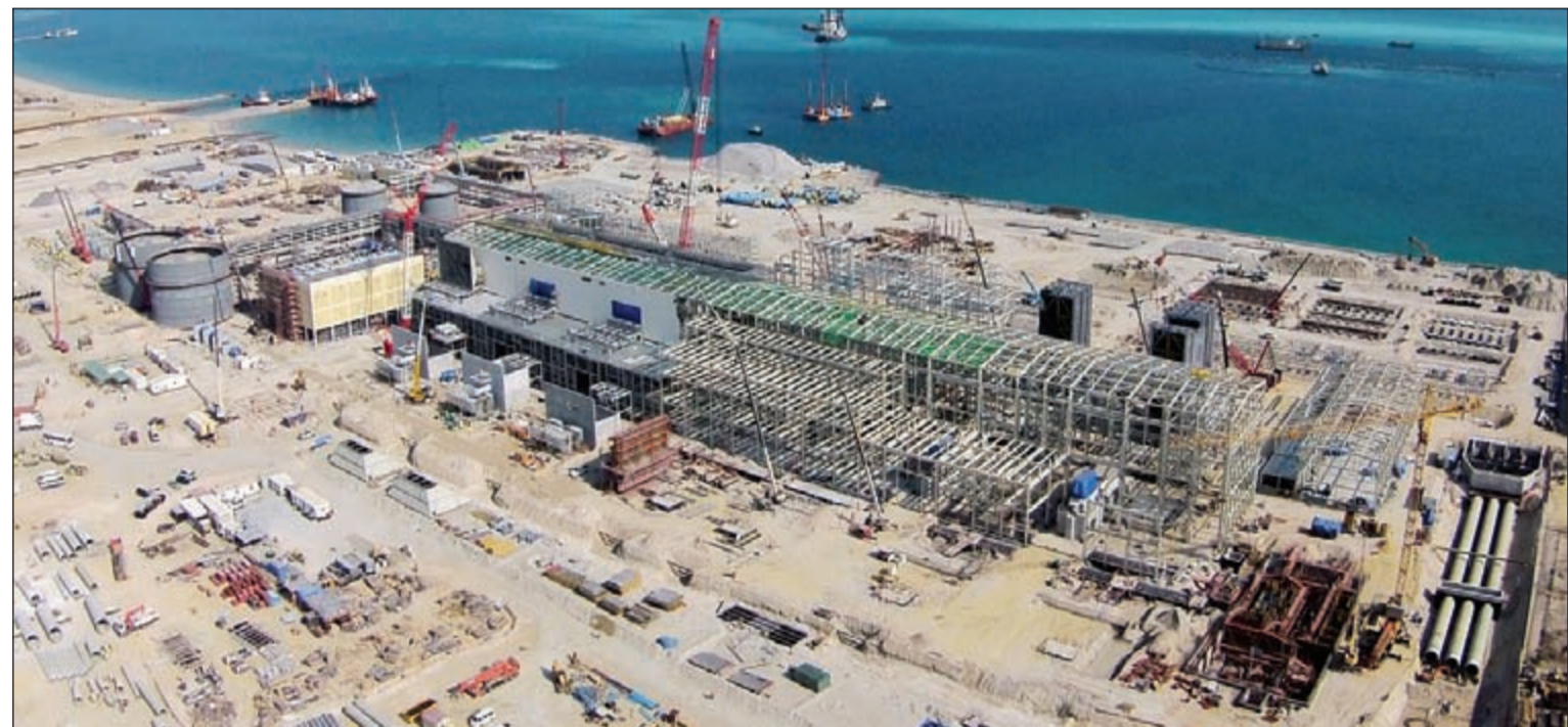
مشاريع البنية التحتية تدعم عمليات النمو وفي الصورة مشروع إنشاء محطة الزور المتوقع توليدها للكهرباء تجارياً بالربع الأخير من 2016
