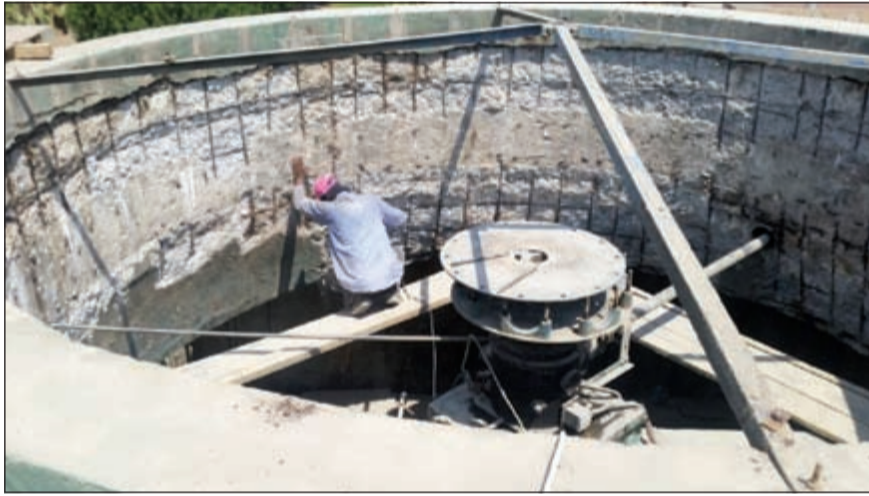
أعمال تجديد أبراج تبريد المحطة المركزية
