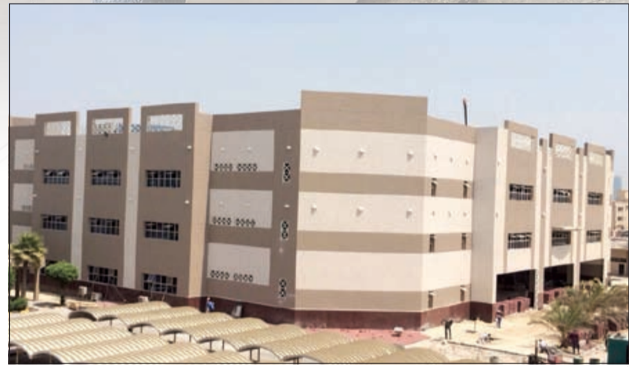
أعمال الصيانة في مبنى الفصول الدراسية بموقع الجامعة بكيفان
