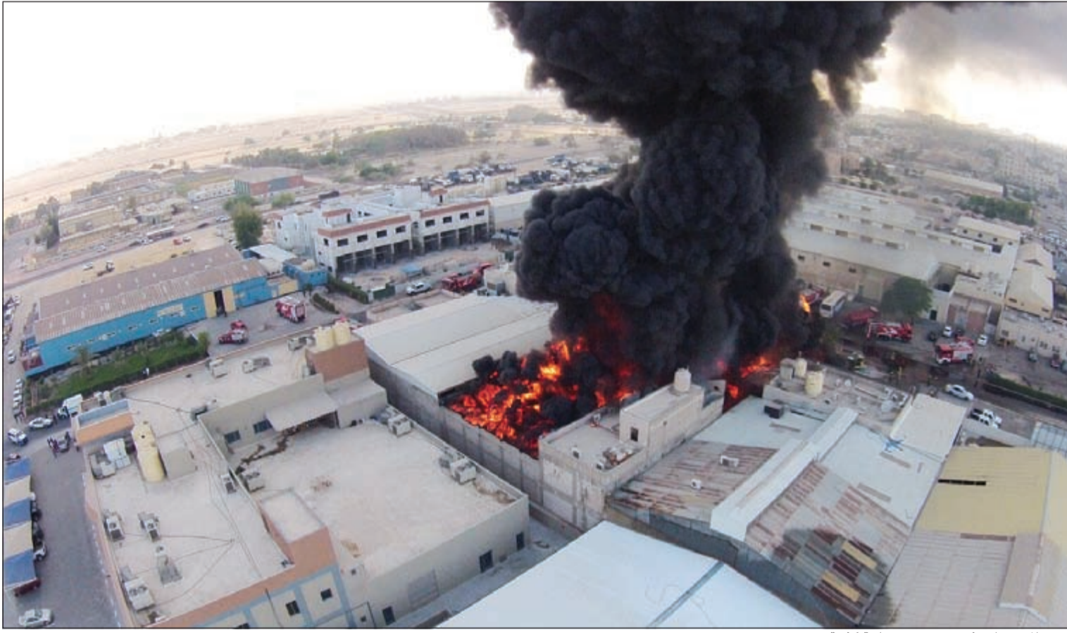
حريق المصنع انبعثت منه سحب دخانية كثيفة
