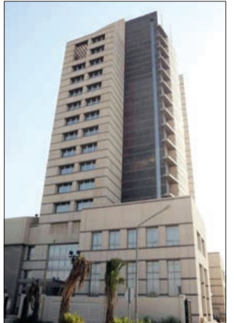
المبنى الجديد لمنطقة مبارك الكبير التعليمية من الخارج
