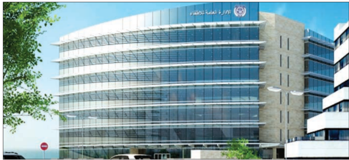
المبنى الجديد للإدارة العامة للإطفاء.
