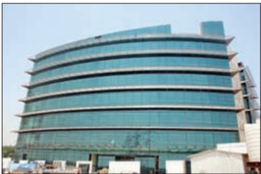
المبنى جارٍ اجراء التشطيبات النهائية بداخله
