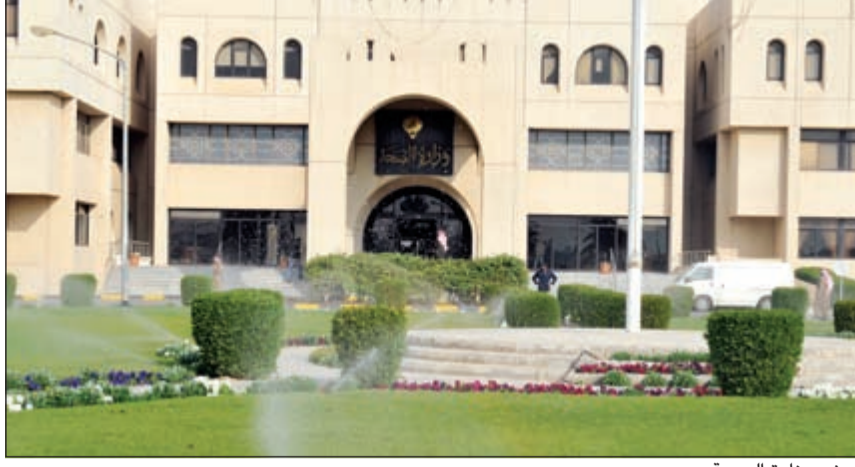
مبنى وزارة الصحة
