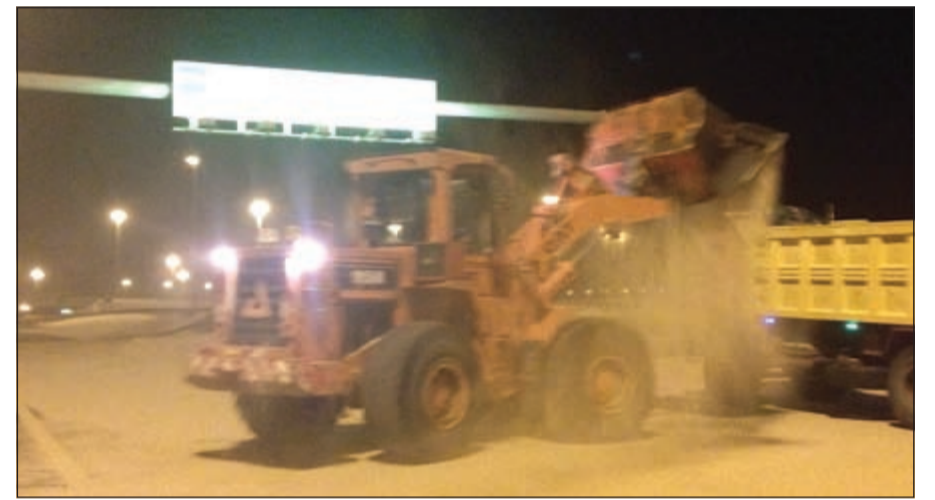
آليات الأشغال تنقل الرمال خارج حرم الطريق
