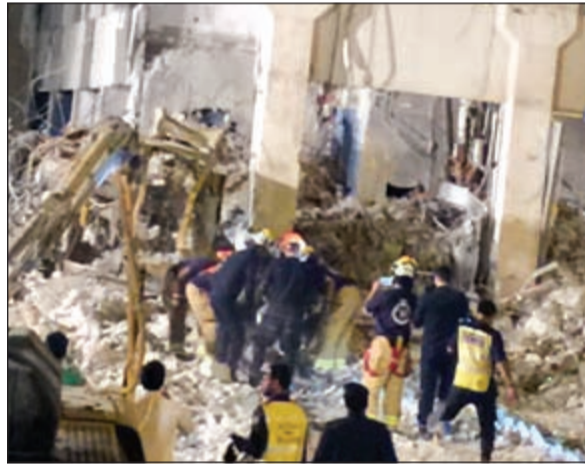
جانب من أعمال الهدم
