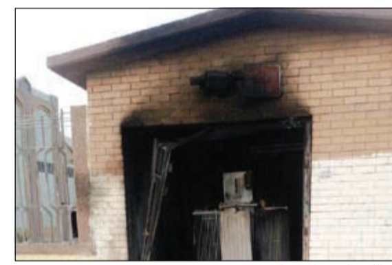
محول الكهرباء بعد الانفجار
