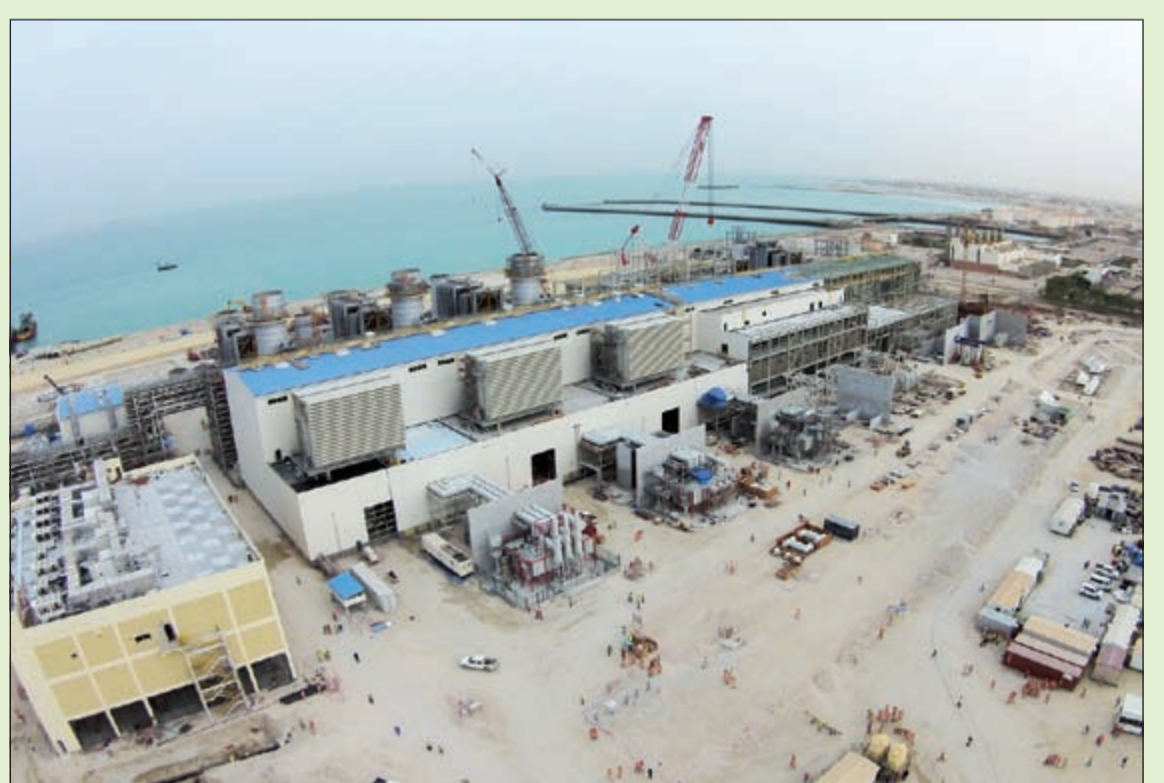
أعمال الإنشاء في محطة الزور الشمالية مستمرة
