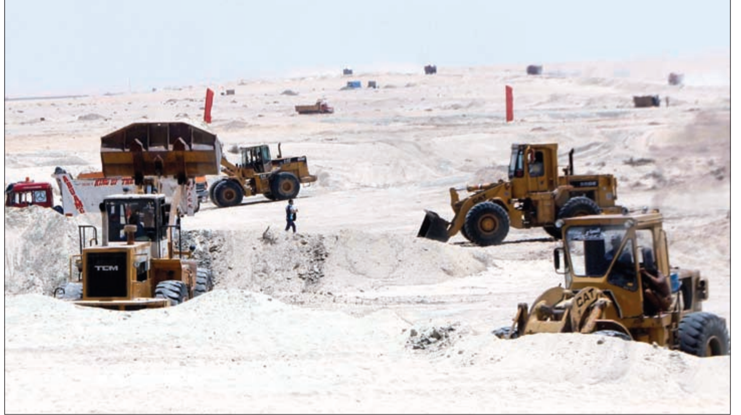
صورة أرشيفية لأعمال الحفر في قناة السويس الجديدة
