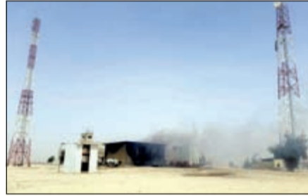
من حريق غرفة مولدات المراكز الحدودية
