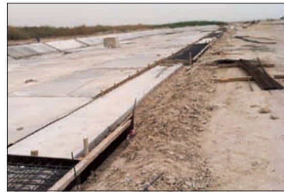
أعمال الإنشاءات بالمشروع
