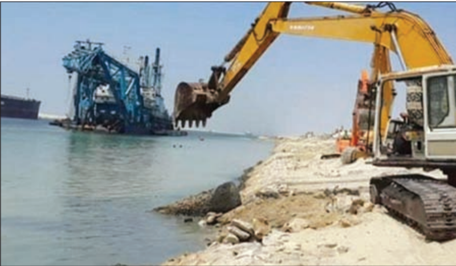
جانب من أعمال الحفر في قناة السويس الجديدة
