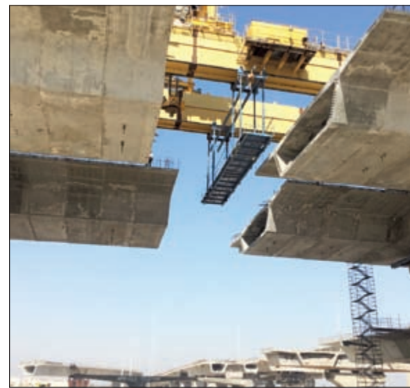
تركيب القطع الخرسانية في الطريق
