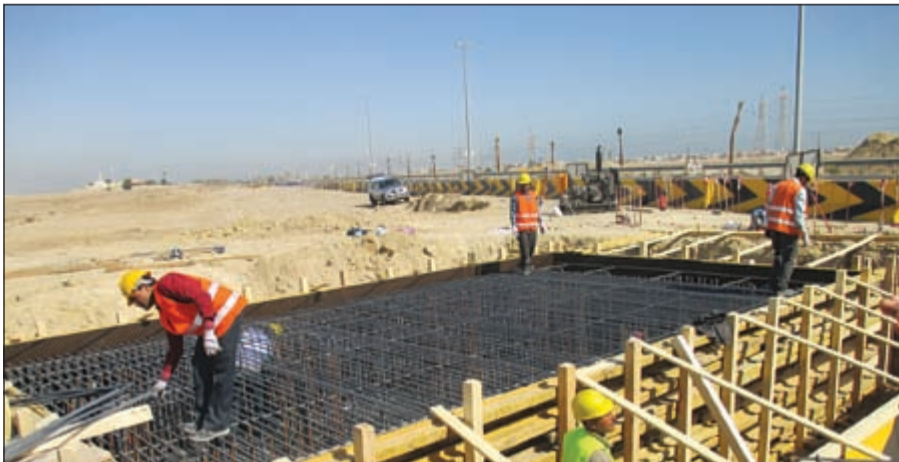
الاعمال الحديدية في طريق النويصيب
