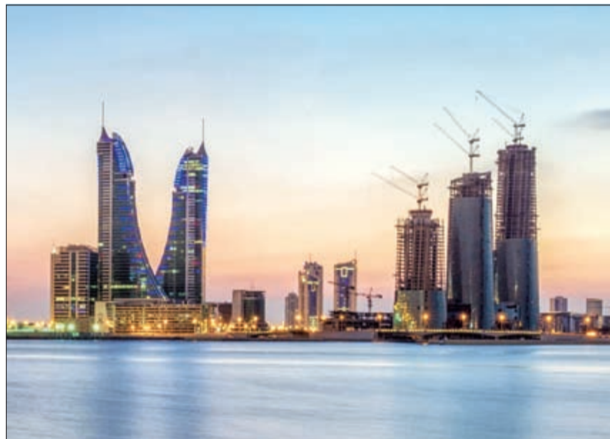
جانب من أعمال التشييد في مشروع فيلامار
