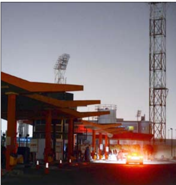
وزارة الكهرباء بملت جهودا كبيرة معالجة فصل التيار احترازيا حماية للشبكة
