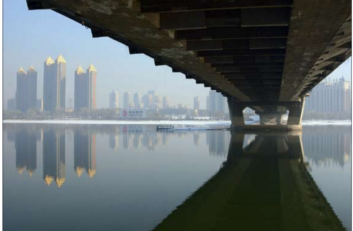
تخطط 14 مقاطعة صينية لتحفيز الاستثمار بها عبر إنفاق 15 تريليون يوان على البنى التحتية ومشروعات أخرى. وفي الصورة أبراج تم بناؤها حديثاً بجوار نهر سونغهوا وجسر في جيلين بمقاطعة جيلين (رويترز)
