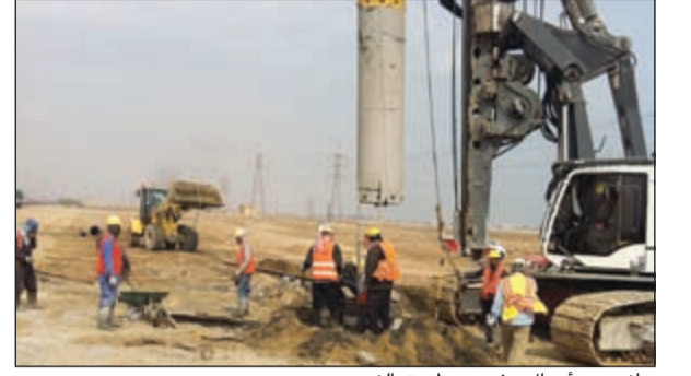
جانب من أعمال مشروع طريق النويصيب
