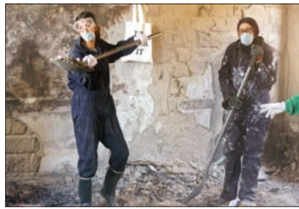
فتيات يشاركن في ترميم البيوت
