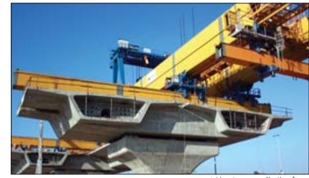
من أعمال الجسور في المشروع
