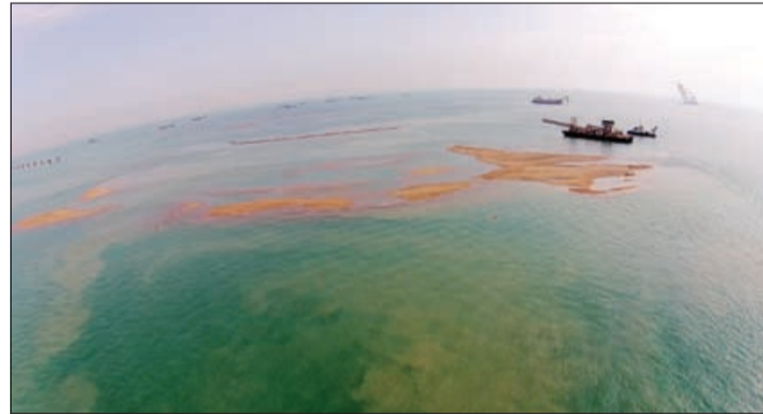
ارتفاع قاع البحر في موقع الجزيرة الشمالية بسبب أعمال الردم
