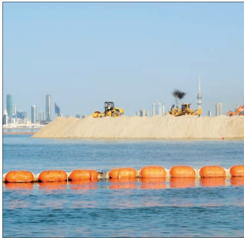
جانب من أعمال الردم في مشروع جسر جابر
